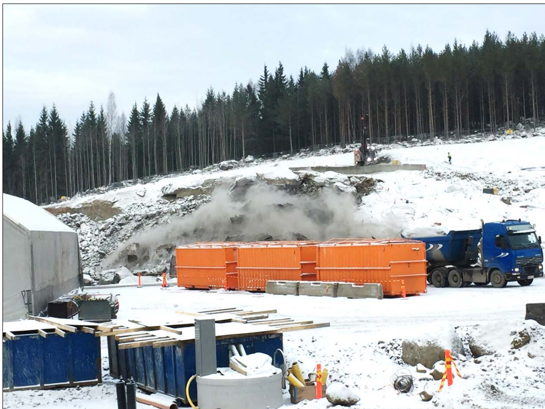
Räjätystyöt käynnissä Sulkavuoren työmaalla joulukuussa.
