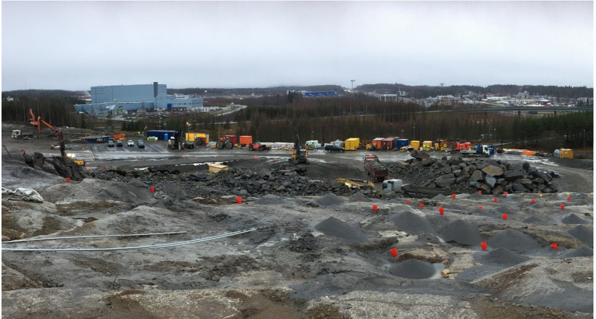
Näkymä työmaalta joulukuussa 2018.
