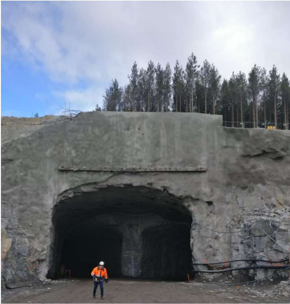
Kuva 2. Sisään- ja ulosajotunneleiden aukko Sulkavuoressa. (Valokuva: Marko Männynsalo)
