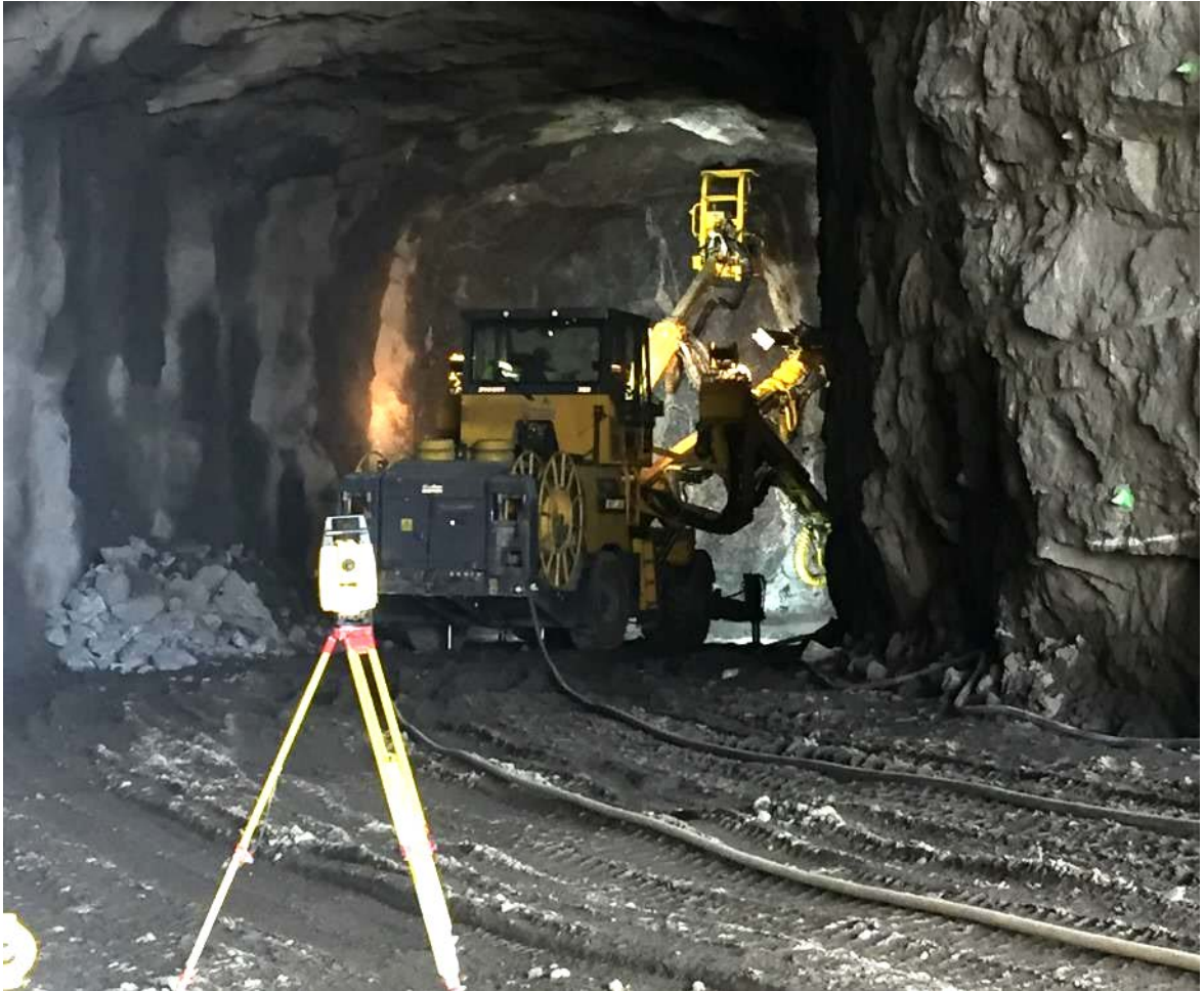
Kuva 1. Kallion poraus käynnissä sisäänajotunnelissa. (Valokuva: Ari-Matti Ilkka).
