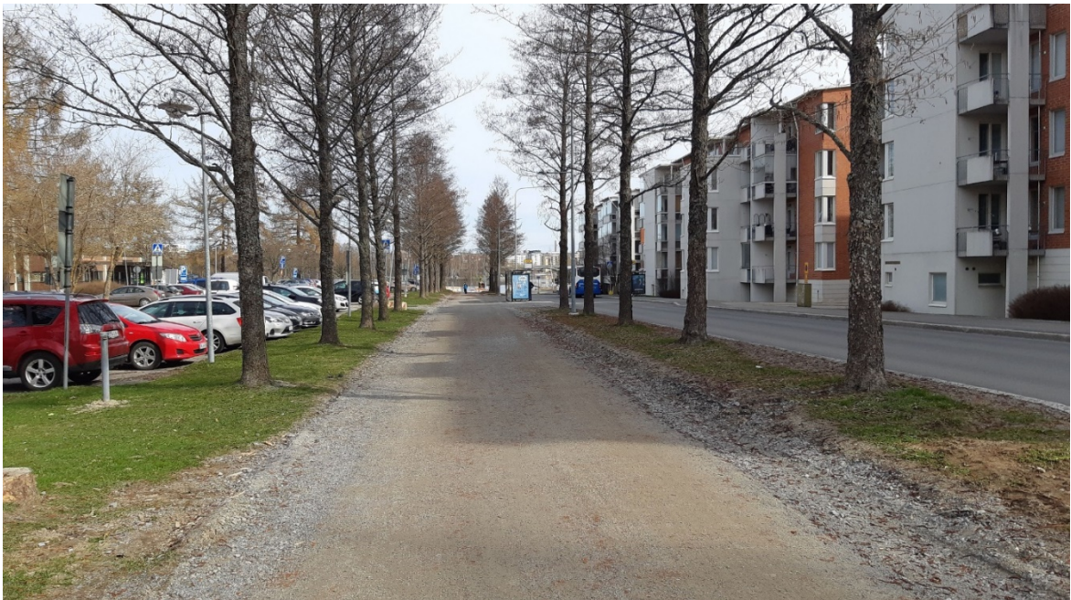
Kuva 15. Siirtoviemäreiden rakentamistyöt Hatanpään sairaalan edustalla on saatu jo valmiiksi, mutta Tampereen kaupunki jatkaa vielä katurakenteiden pintatöitä kesän 2021 aikana (Kuva: Tatu Hoikkala, Ramboll Finland).
