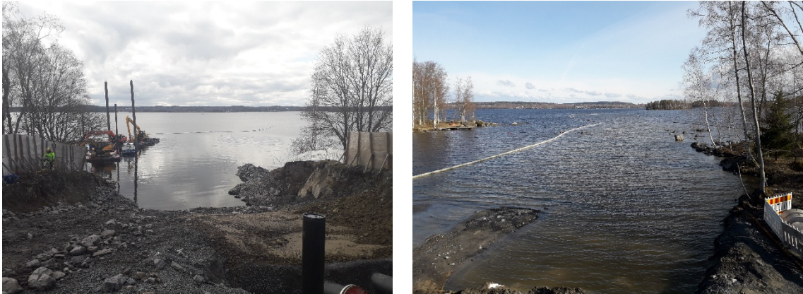
Kuva 14. Työmaan ranta-alueet Raholassa ja Haikassa töiden jatkuessa (Kuvat: Tarmo Toivonen).
