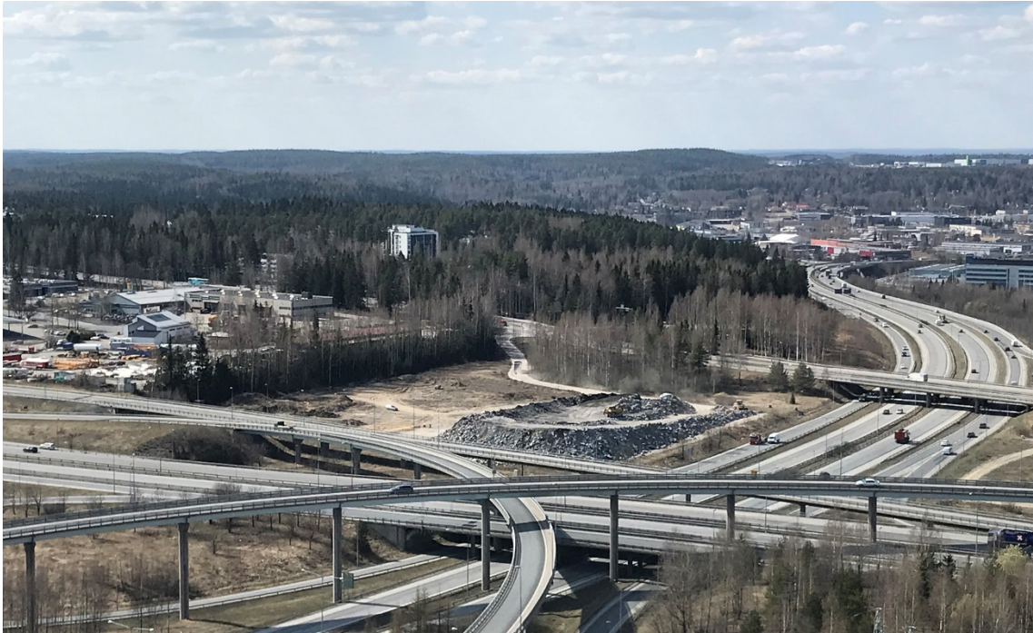
Kuva 8. Kuvassa keskellä Lakalaivan eritasoliittymän lähellä oleva ”Rotatorin tontti”, johon loput louhe väli-varastoidaan. (Kuva: Ari-Matti Ilkka)
