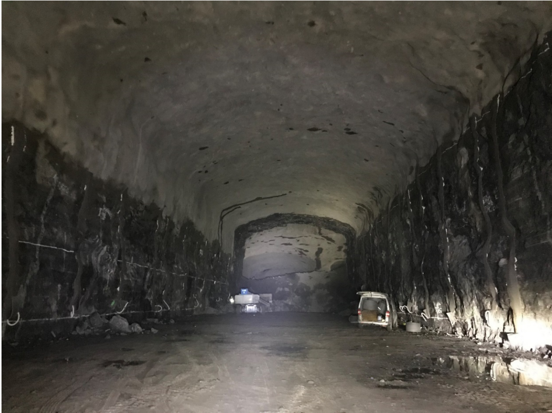
Kuva 5. Louhittua ja lujitettua tunnelia Sulkavuoressa. Tunnelin katto ja seinät on myös salaojitettu sekä osittain "ruiskubetonoitu". (Kuva: Ari-Matti Ilkka).
