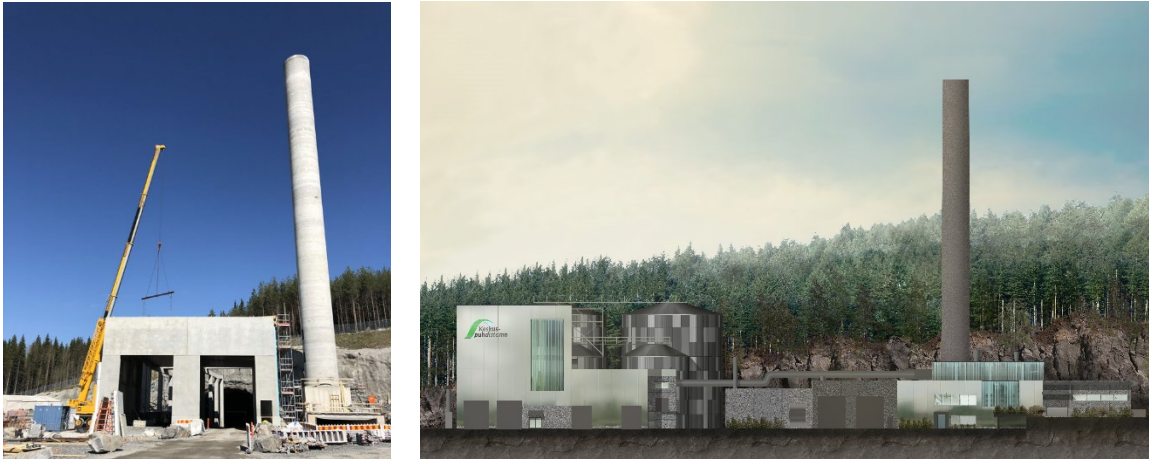
Kuva 9. Vasemmanpuoleisessa kuvassa poistoilmapiippu ja ajotunneleiden suuaukot. (Kuva: Henri Hakala). Oikeanpuoleisessa havainnekuvasa nähdään miten piippu ja ajotunneleiden suuaukot sijoittuvat suhteessa muihin maanpäällisiin rakennuksiin. (Havainnekuva: Ramboll Finland Oy).
