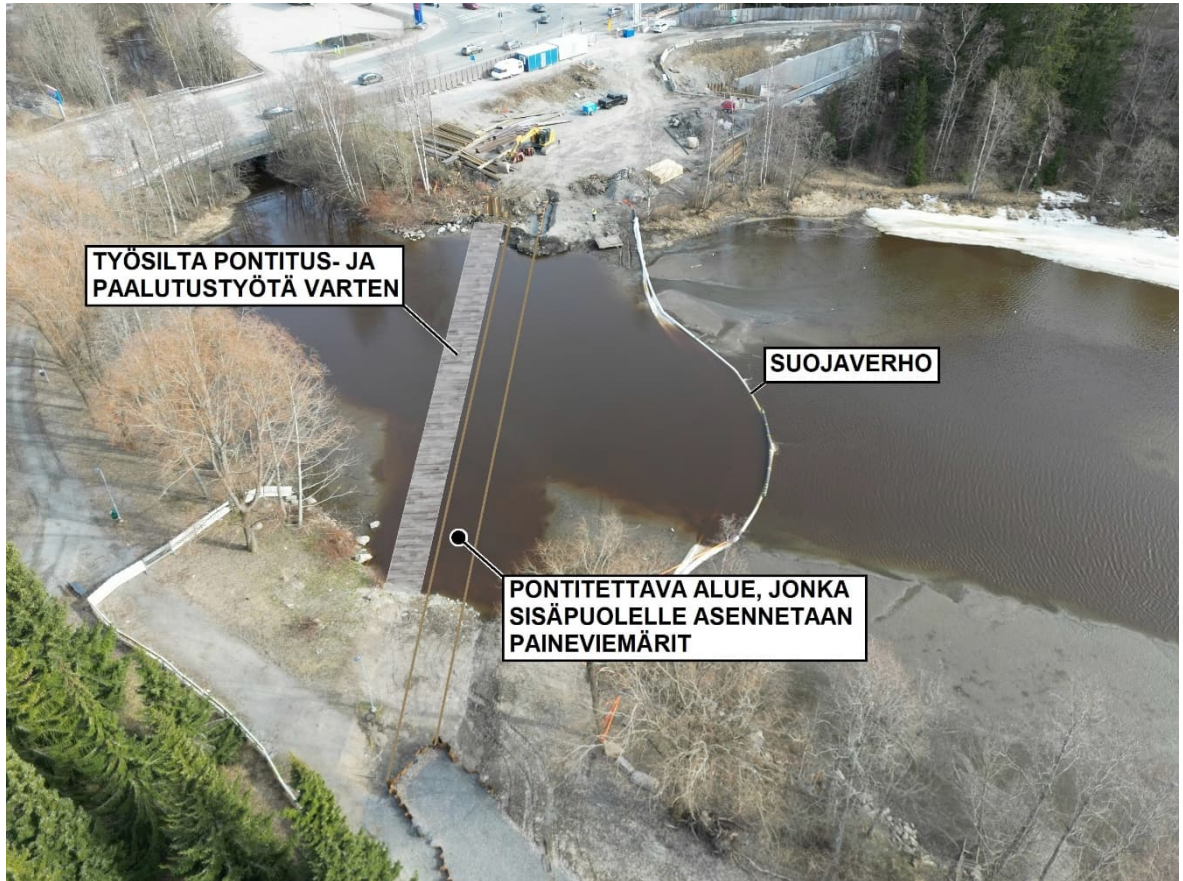
Kuva 10. Vesistöosuudella työsilta tehdään ensin ja sen jälkeen sillalta lyödään pontit tulevan putkilinjan molemmin puolin. Ponttikaivannosta pumpataan vesi noin 2 m järven pintaa alemmaksi ja putket asennetaan puupaalujen varaan lahden pohjan pinnan alapuolelle painotettuina (kuva: Henri Paasonen, stillisointi Ari-Matti Ilkka)
