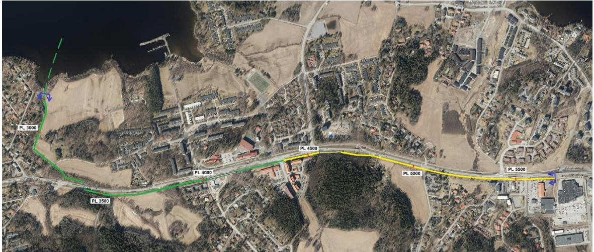
Kuva 6. PV2-urakan urakka-alue kartalla; valmistunut osuus vihreällä, keskeneräinen osuus keltaisella (putket asennettu, mutta pintatyöt tekemättä).
