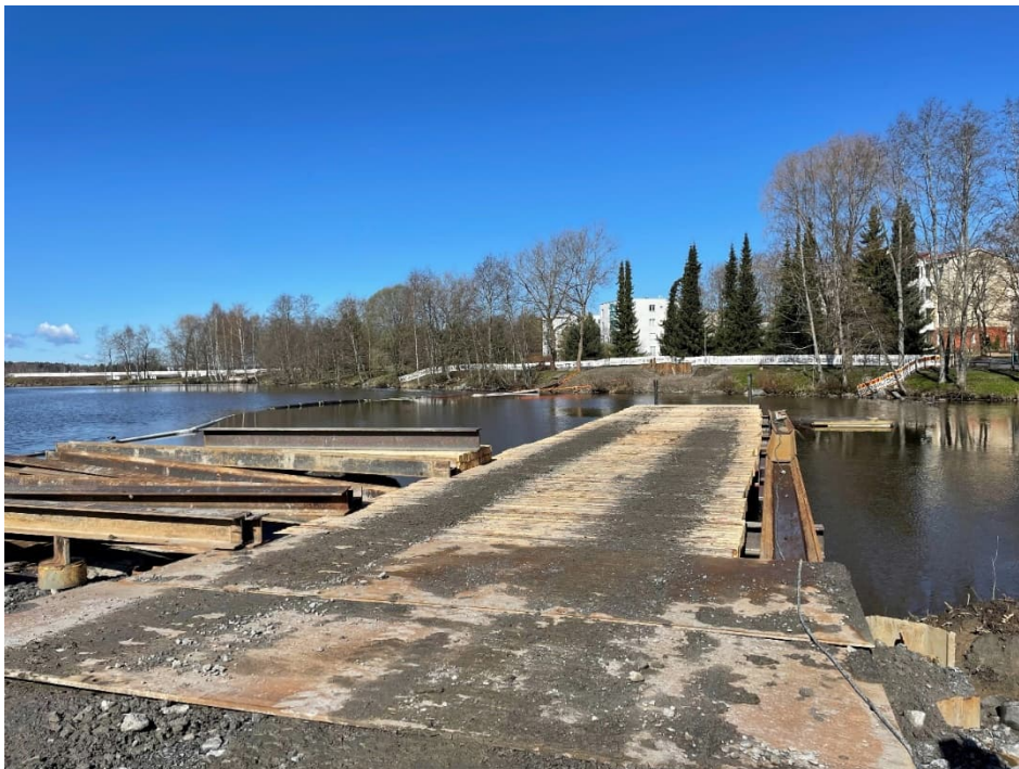
Kuva 11. Työsilta rakenteilla (kuva: Ari-Matti Ilkka)
