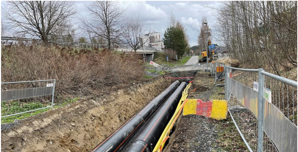
Kuva 7. Viimeiset paineviemäriputket asennettuina Partolan päässä (kuva: Ari-Matti Ilkka)
