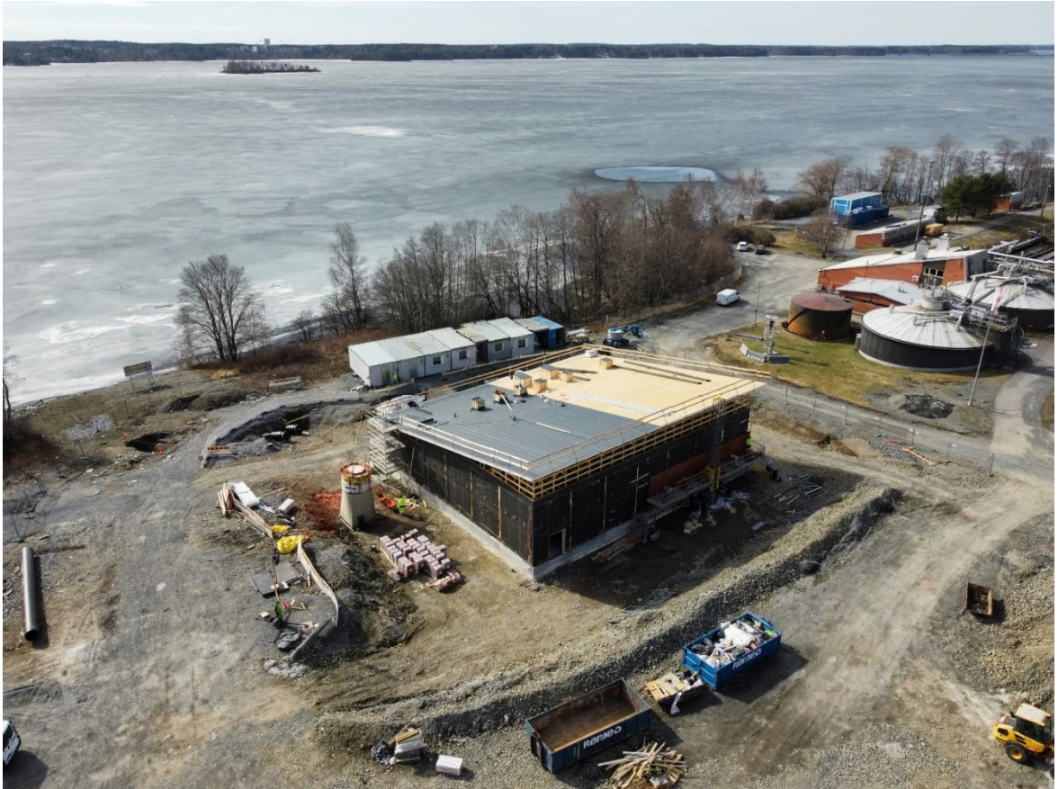
Kuva 13. Raholan pumppaamon julkisivumuuraukset ja peltikattotyöt käynnissä toukokuussa 2023 (Kuva: Jouni Salminen, NYAB Finland Oy).
