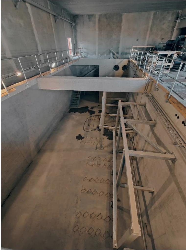
Kuva 14. Raholan pumppaamon pumppusalin teräsrakenteita (Kuva: Marko Männynsalo).
