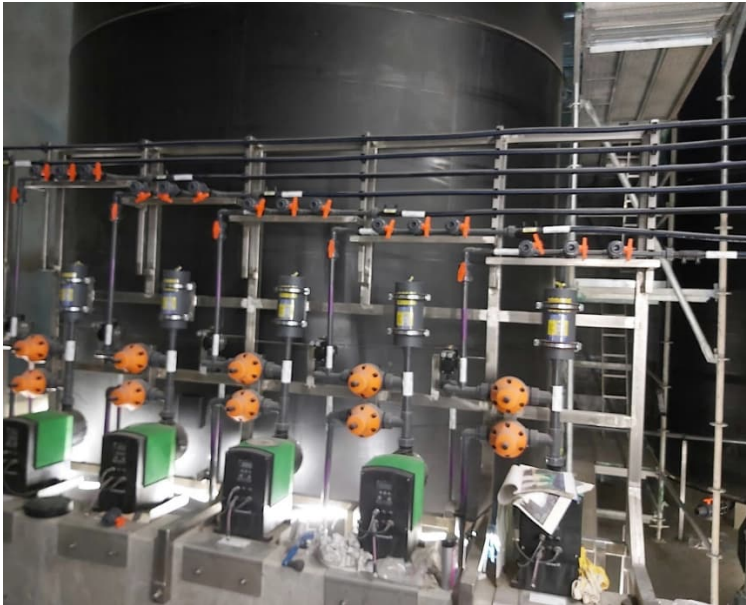
Kuva 3. Kemikaalialueen annostelupumppujen asennukset valmistumassa. (Kuva: V-M Hatvala).
