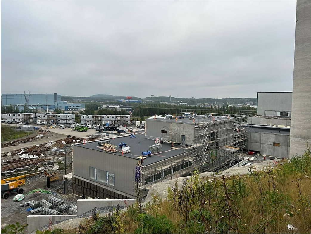
Kuva 2. Näkymä työmaalle hallintorakennuksen takaa. (Kuva: Henri Hakala)
