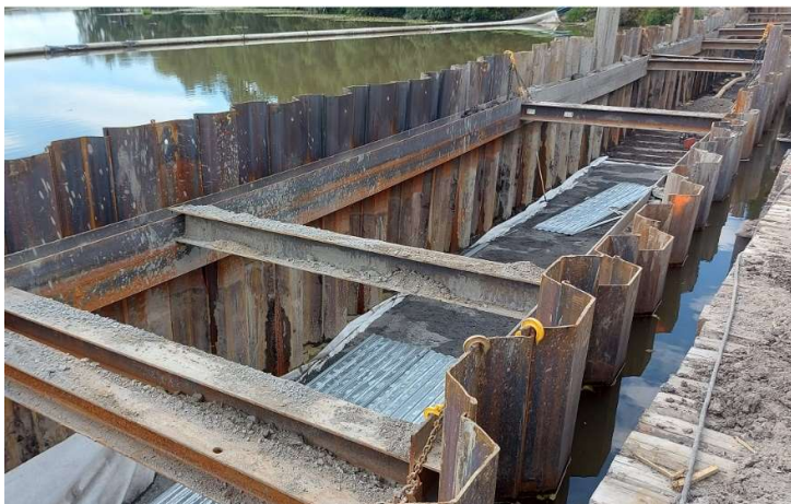
Kuva 15. Vasemmassa kuvassa puupaalujen varaan asennettu peltiarina, jonka päälle murskearina tekeillä. Oikeassa kuvassa putken asentaminen kaivantoon meneillään (kuvat: Ari-Matti Ilkka)
