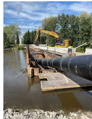
Kuva 15. Vasemmassa kuvassa puupaalujen varaan asennettu peltiarina, jonka päälle murskearina tekeillä. Oikeassa kuvassa putken asentaminen kaivantoon meneillään (kuvat: Ari-Matti Ilkka)
