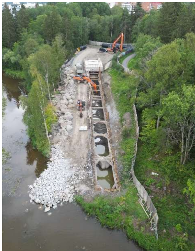
Kuva 10. Vasen kuva PK3 kuilulta rantaan tehdystä tuetusta kaivannosta ja oikea kannaksen kohdalta, jossa 110 kV sähkökaapeli on tuettuna. Huom! tässä kuvassa ei ole vielä silta asennettuna (kuvat: Ramboll CM / Henri Paasonen).
