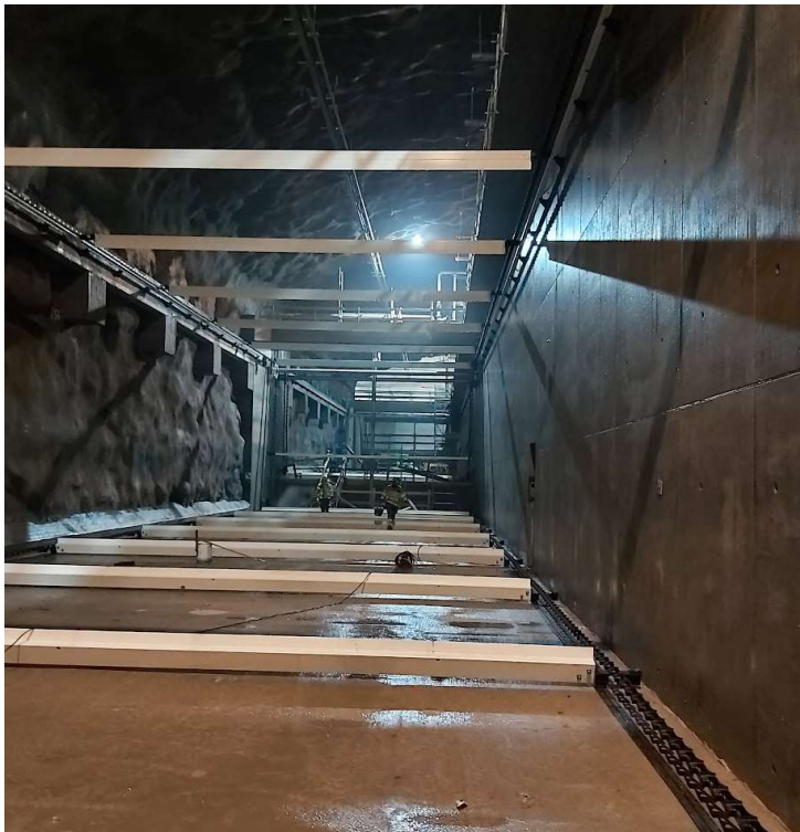
Kuva 4. Laahainasennus jälkiselkeytsaltaassa. (Kuva: Veli-Matti Hatvala)
