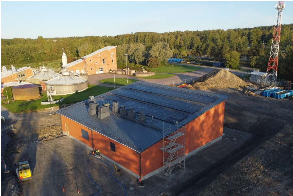
Kuva 17. Raholan pumppaamon rakennustyöt alkavat olla loppusuoralla. (Kuva: Jouni Salminen, NYAB Finland Oy).
