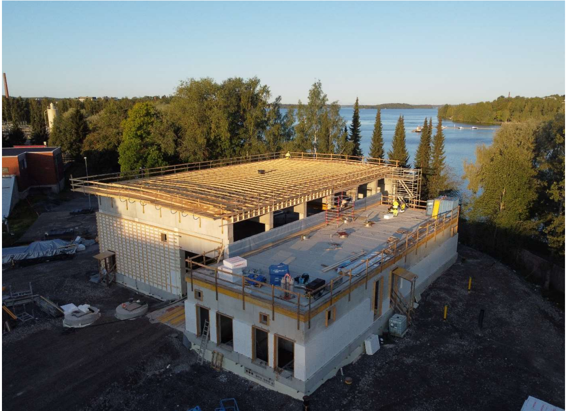
Kuva 16. Viinikanlahden pumppaamorakennus alkaa hahmottua tontilla. (Kuva: Jouni Salminen, NYAB Finland Oy).
