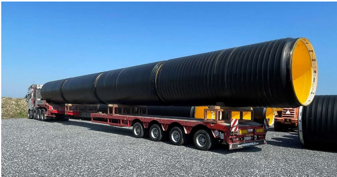
Kuva 12. Kuva putkirekasta, joka on juuri tullut Virosta Krah:n putkitehtaalta ja odottaa kuorman purkua (kuva: Ari-Matti Ilkka).
