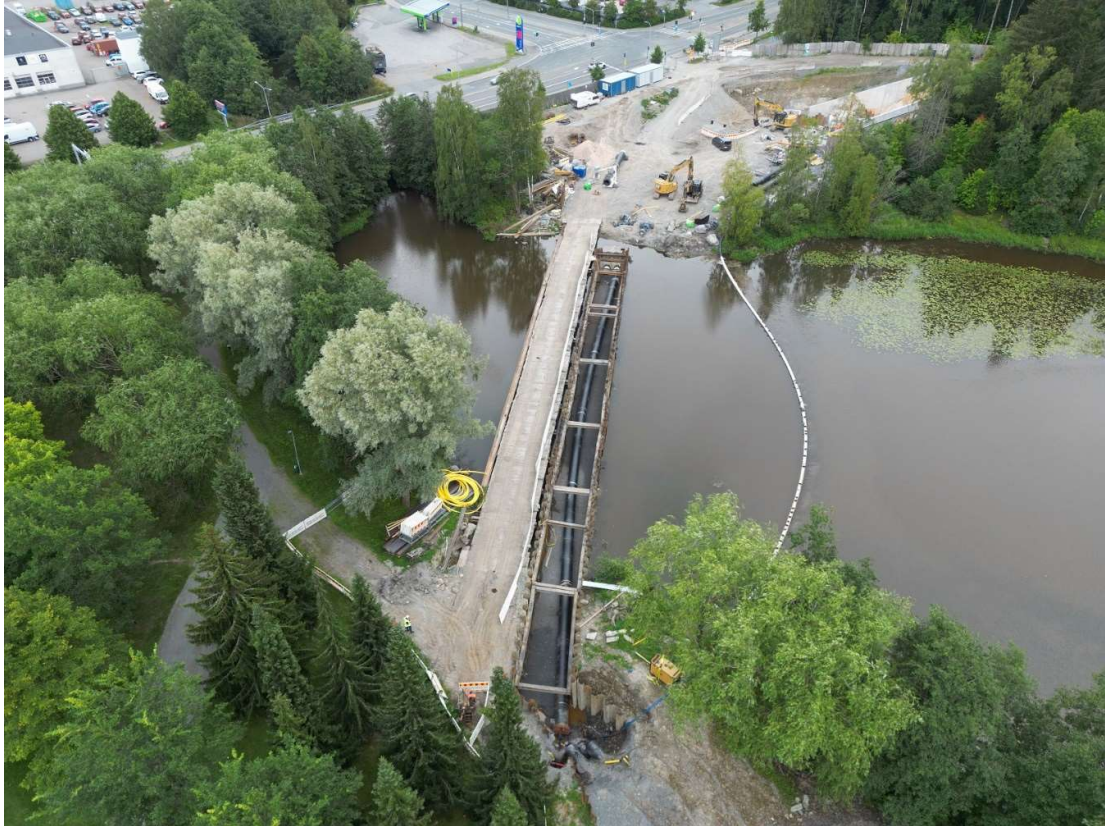
Kuva 14. Vesistöosuudella toinen putki on asennettu kaivantoon (kuva: Ramboll CM / Henri Paasonen)
