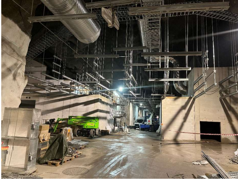
Kuva 5. Sähköhyllysten ja niiden kannakkeiden asennukset käynnissä. (Kuva: Petri Ylönen)
