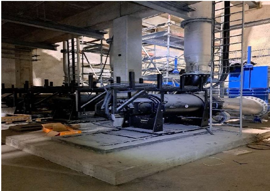
Kuva 6. Tulopumppujen sähköasennukset meneillään. (Kuva: Petri Ylönen)
