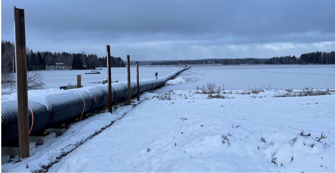
Kuva 13. Kuva 480 m pitkstä putkietkasta Sankilanlahdella. Putki on kuvan oton jälkeen merkitty vielä heijastavin kepein sekä varoituskyltein jäällä liikkuvia varten. (kuva: Ari-Matti Ilkka).
