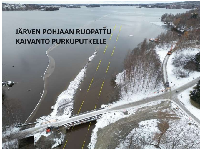
Kuva 11. Vasen kuva PK3 kuilulta rantaan tehdystä tuetusta kaivannosta ja oikea kannaksen kohdalta, jossa 110 kV sähkökaapeli on tuettuna, klv-silta asennettuna sekä ruopattu putkiura esitetty keltaisella katkovivalla (kuvat: Ramboll CM / Henri Paasonen).
