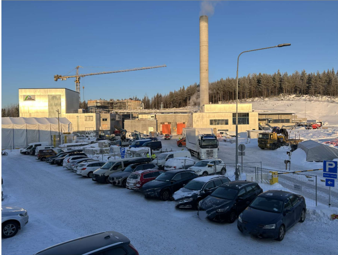
Kuva 2. Näkymä työmaalle. (Kuva: Henri Hakala)
