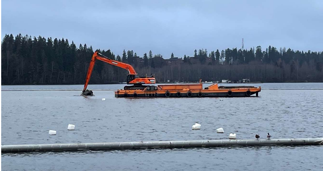
Kuva 12. Putkiuran ruoppaus käynnissä Vihilahdessa (kuva: Ari-Matti Ilkka)
