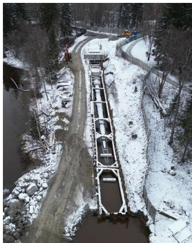
Kuva 11. Vasen kuva PK3 kuilulta rantaan tehdystä tuetusta kaivannosta ja oikea kannaksen kohdalta, jossa 110 kV sähkökaapeli on tuettuna, klv-silta asennettuna sekä ruopattu putkiura esitetty keltaisella katkovivalla (kuvat: Ramboll CM / Henri Paasonen).
