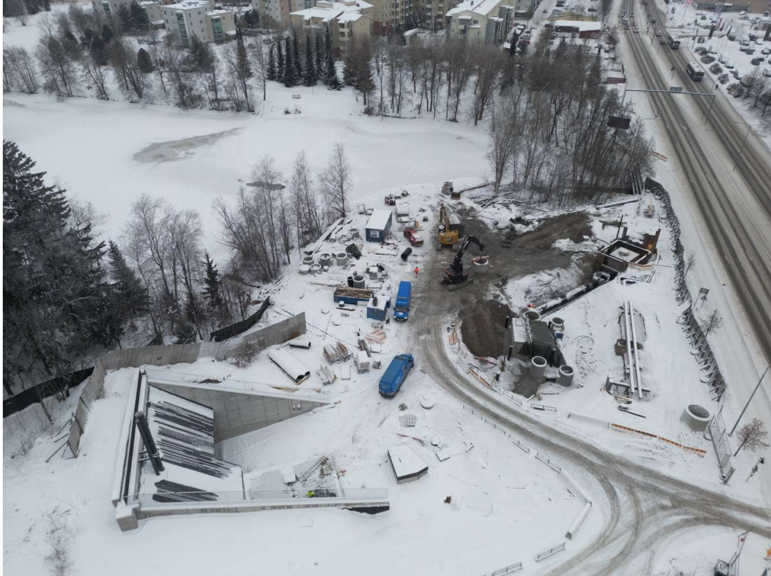
Kuva 14. Kuva otettu joulukuun 2023 alussa, jolloin työt olivat vielä kesken lähinnä liitos- ja mittauskaivojen alueilla (kuva: Ramboll CM / Henri Paasonen)
