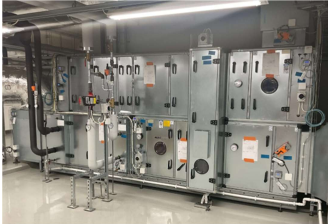
Kuva 8. Hallintorakennuksen IV-koneistusta (Kuva: Jarkko Kestilä, Ramboll CM)
