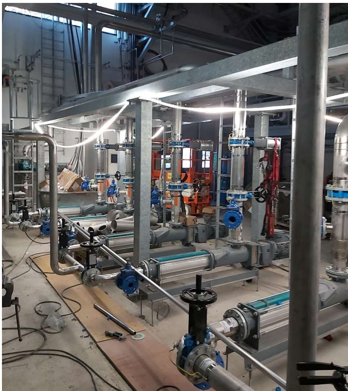
Kuva 5. Lieterakennuksesta lietepumppuasennuksia. (Kuva: Veli-Matti Hatvala)
