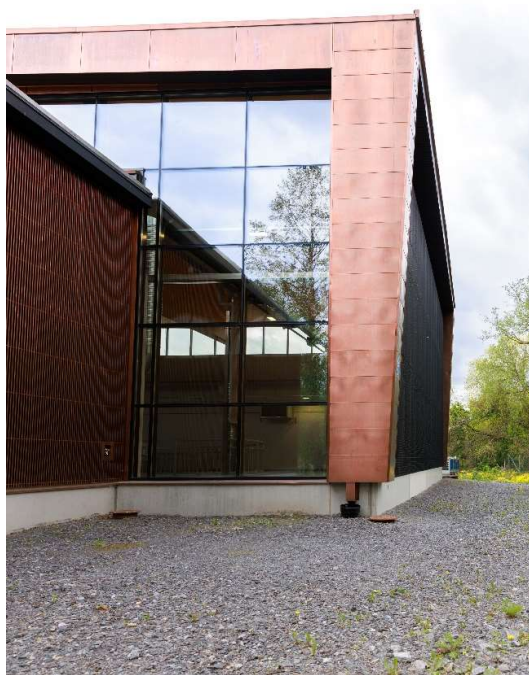
Kuva 4. Viinikanlahden jätevedenpumppaamon arkkitehtuuria. (Kuva: Annamaria Palsi-Ikonen)
