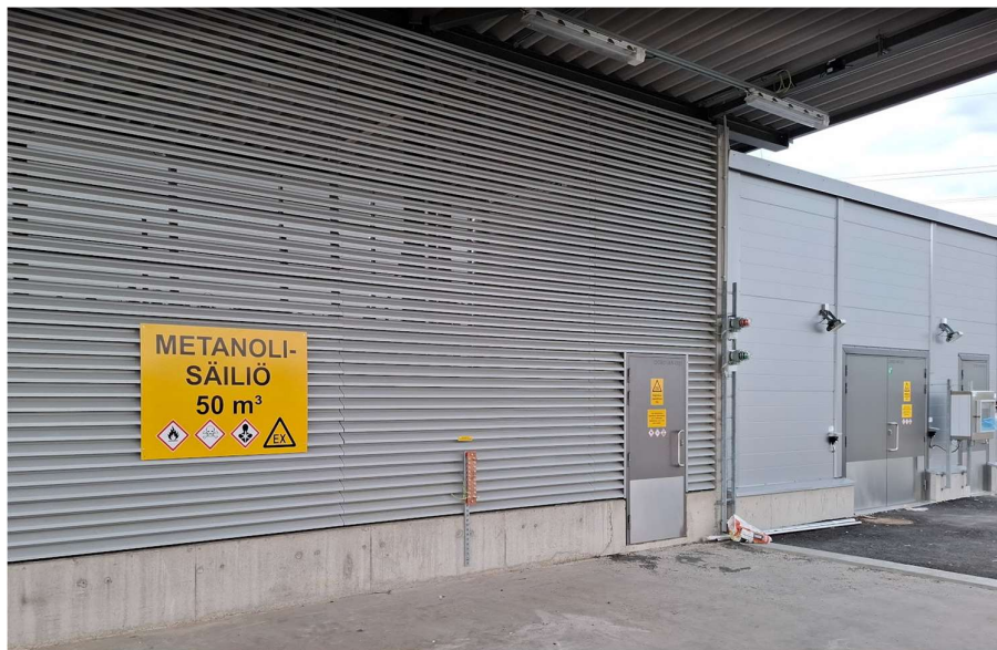
Kuva 3. Metanoliaseman loppuhetken viimeistelytöet ennen metanolin vastaanottoa. (Kuva: Veli-Matti Hatvala)
