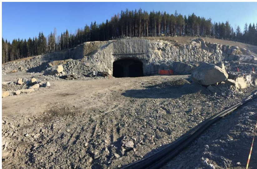
Kuva 3. Kuva Sulkavuoren työmaalta ensimmäisen louhintaurakan aikaan. (Kuva: Ari-Matti Ilkka).
