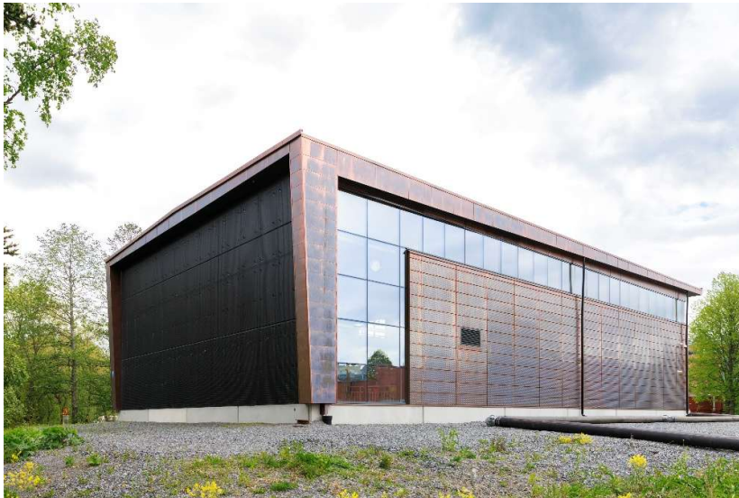
Kuva 7. Viinikanlahden jätevedenpumppaamo. (Valokuva Annamaria Palsi-Ikonen).
