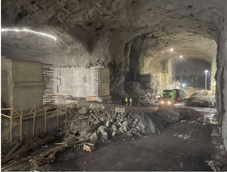
Kuva 5. Toisessa louhintaurakassa louhittiin varsinaiset puhdistamotilat. (Kuva: Henri Hakala).
