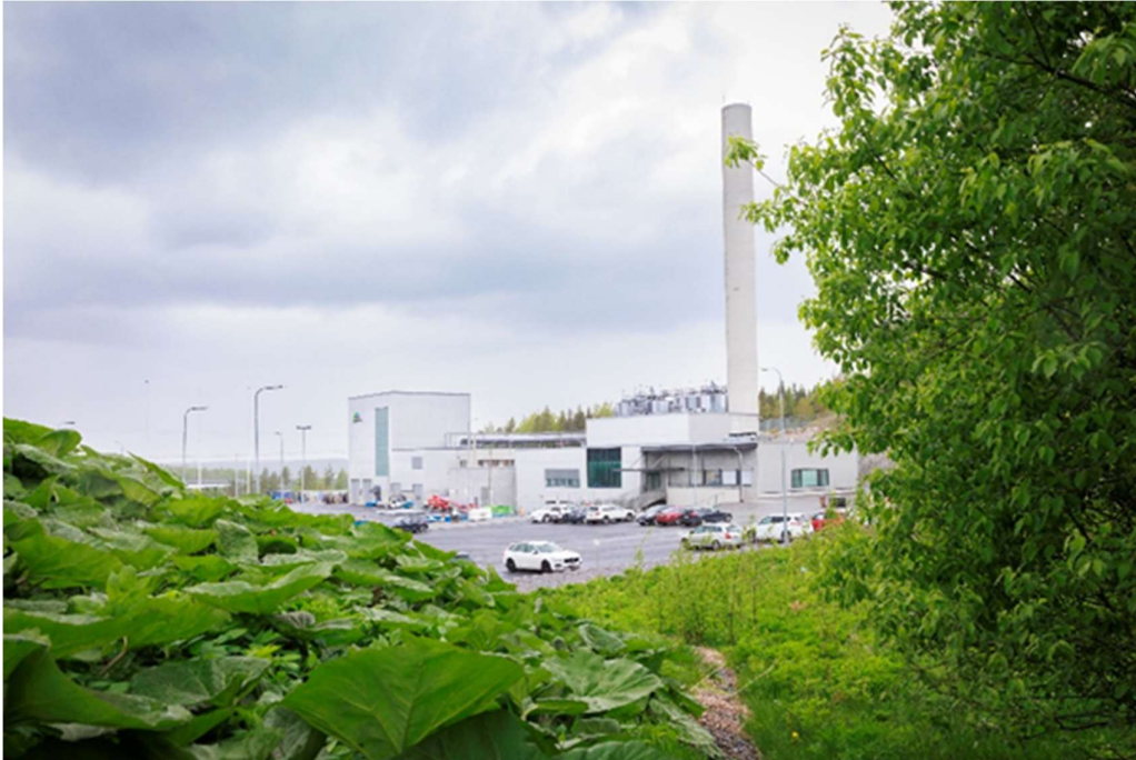
Kuva 6. Valmiin keskuspuhdistamon maan päälliset tilat (Kuva: Annamaria Palsi-Ikonen).
