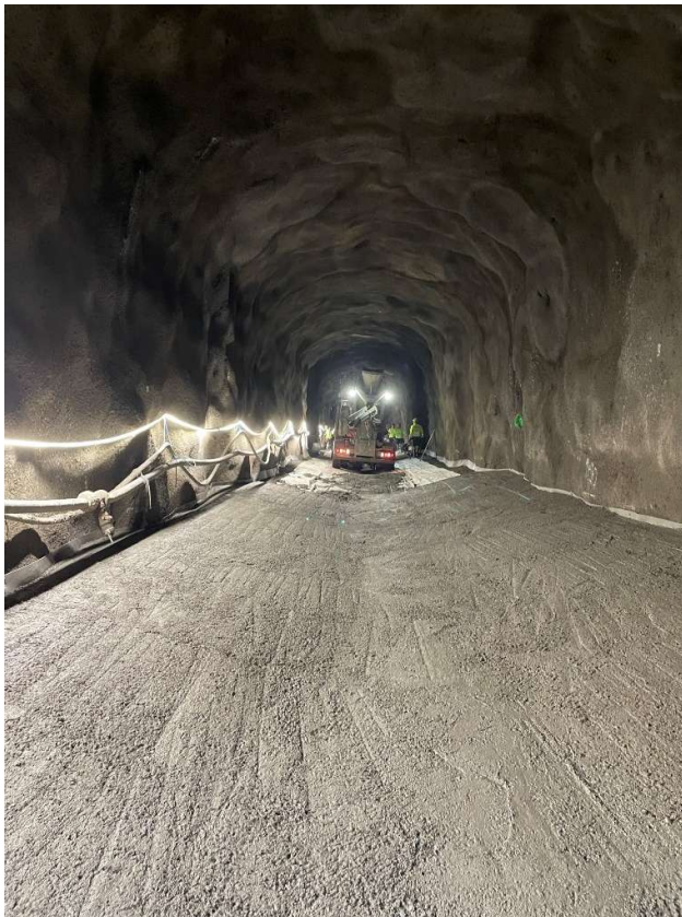
Kuva 4. Siirtotunnelin pohjan valu v-muotoon käynnissä. (Kuva: Henri Hakala).
