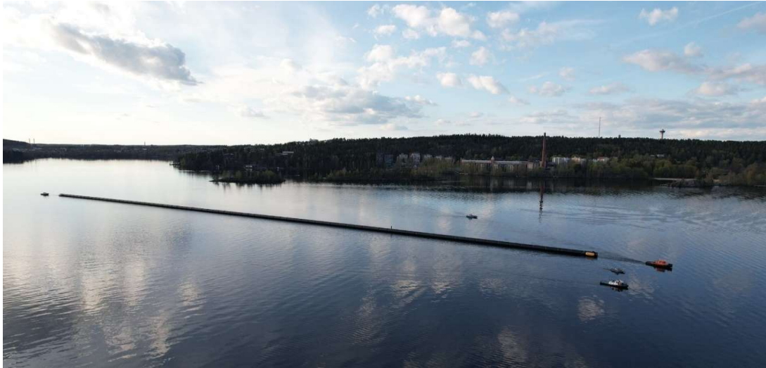
Kuva 8. Purkuputken putkiletkan siirto Sankilasta kokoamispaikalta Vihilahteen toukokuussa 2024 (kuva: Timo Rajakallio / Creative Ky)
